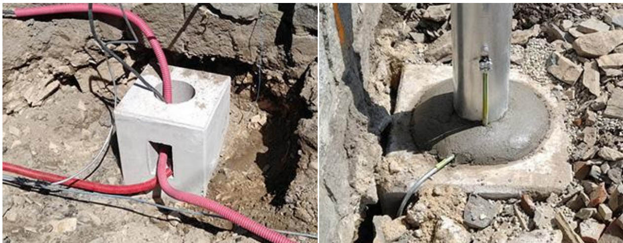
Obrázek 10 a 11: Prefabrikovaný stožárový ŽB základ pro vetknutý stožár
