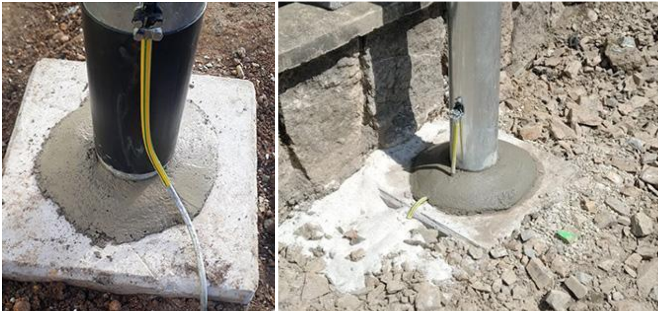
Obrázek 2 a 3: Provedení připojení zemního drátu FeZn 10 ke stožáru VO
