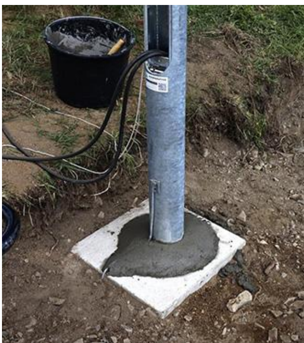
Obrázek 8 a 9 - Příklad třístupňového stožáru a prefa ŽB základu pro montáž vetknutého stožáru
