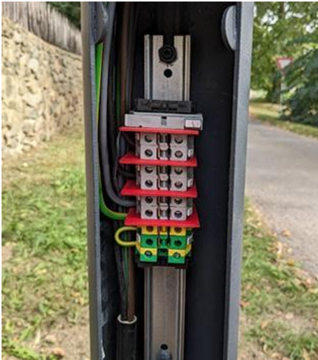
Obrázek 5 a 6: Ukázka vhodného provedení kabelové rezervy formou smyčky, a připojení přívodního kabelu do stožárové svorkovnice a schéma zapojení kabeláže ve stožárové svorkovnici
